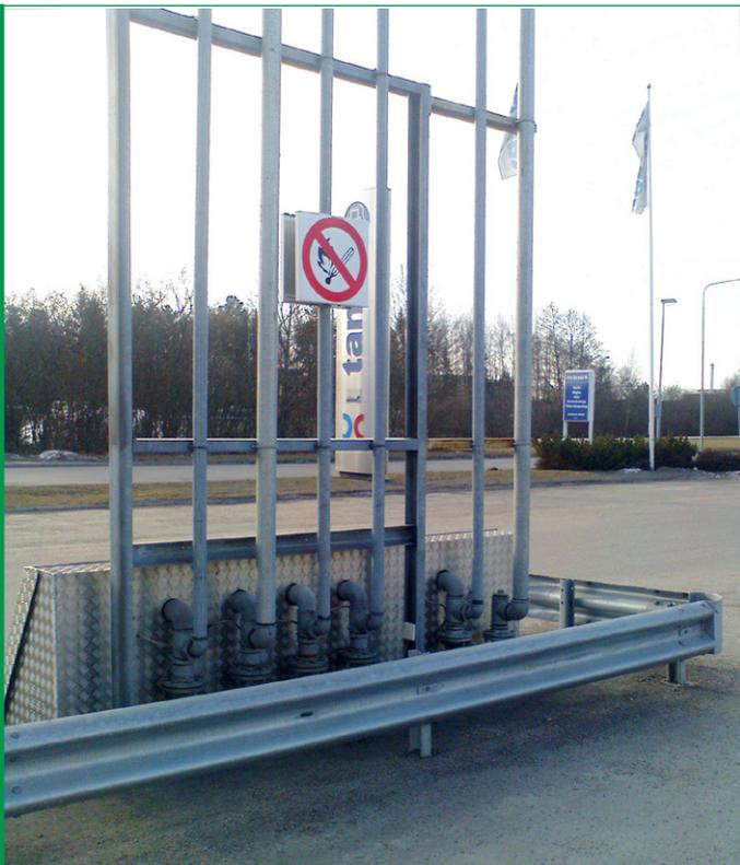
Ventilacijski stup treba ugraditi u ispravnom položaju i učvrstiti ga prije početka ugradnje cijevi. Ventilacijske cijevi treba pravilno poduprti da bi se spriječilo preokretanje.
