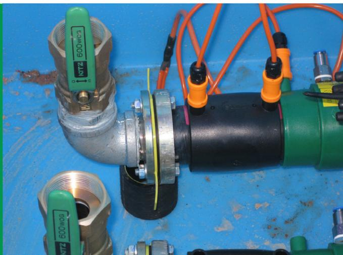
*Ako je potrebno tijekom zavarivanja poduprite cijevi unutar i izvan komore.*
