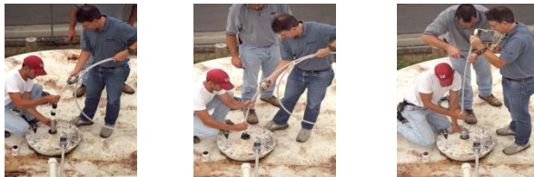
Figura 4-5 Instalación del Adaptador, Flota y Peso
