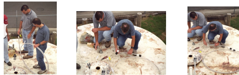
Figura4-4 Instalación de la Sonda
