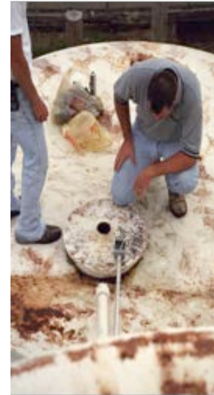
Figura 4-6 Instalación de la Sonda Flexible
