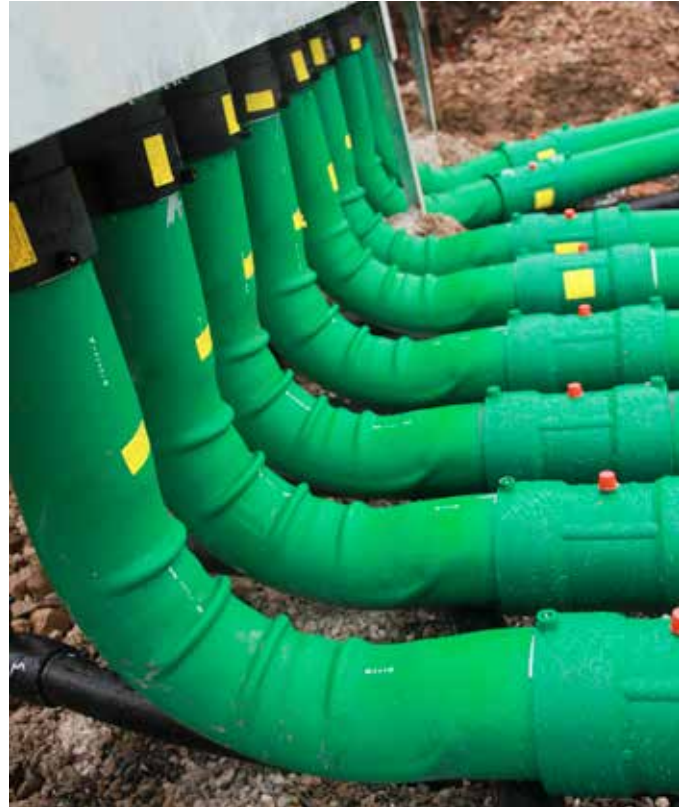
KPS bends below fill point
