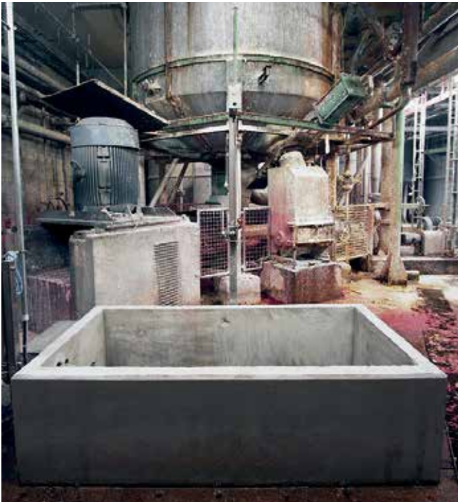
Papierwerke Lenk groundwater collector
