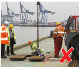
Tapas de acero pesadas y degradadas que requieren una grúa y equipo de elevación específico
