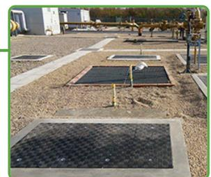
**Resistente a la corrosión: las tapas y paneles de material compuesto PRFV son una opción obvia cuando se trata de agua residual o líquidos corrosivos.**
