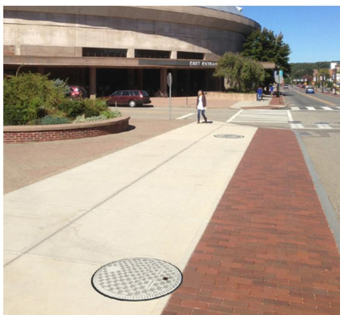
**Resistente a la corrosión: las tapas de material compuesto PRFV son una opción obvia cuando están involucrados aguas residuales o líquidos corrosivos.**
