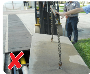
Niebezpieczna technika przesuwania bez użycia rączki Fibrelite.
