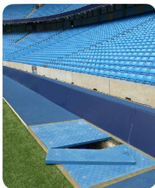
**Faserverbund ist eine perfekte Alternative zu schweren Abdeckungen aus Beton und korrosionsanfälligen Metallabdeckungen**
