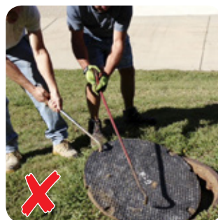
Niebezpieczna technika przesuwania bez użycia rączki Fibrelite.
