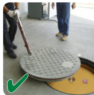
Bezpieczna technika przesuwania przy użyciu rączki Fibrelite.
