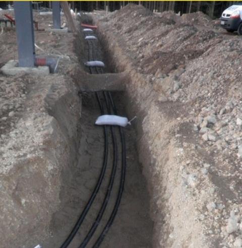
*Das KPS-LPG-Rohr ist absolut korrosionsfrei. Stahlrohre und andere Rohre können sowohl innen als auch außen korrodieren, wodurch Probleme mit Partikeln entstehen, die die Zapfsäulen beschädigen. Darüber hinaus besteht die Gefahr von Undichtheiten in den Boden. KPS bietet eine Lösung für diese Probleme.*
