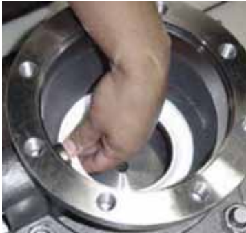
Figure 15 - Instalando el primer sello de bola
