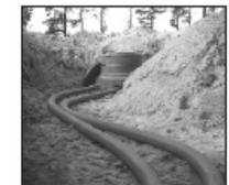
**Paso 3.** Introduzca la parte de la funda del ducto en la pared del sumidero. Instale el ducto holgadamente en la funda y mida del frente al frente de la T coaxial o codos conectores previamente instalados dentro de cada sumidero. Corte la tubería flexible Flex a esta longitud con un cortador de tubería OPW-FCS. **NO ACOPLA LA TUBERÍA.**
