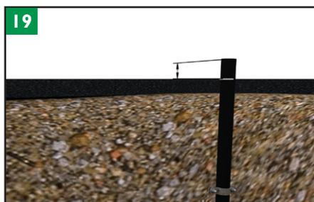
19 Colocar el tubo en la zanja y medir y marcar la altura exacta requerida. El tubo ha de terminar al nivel de la posición de bombeo.
