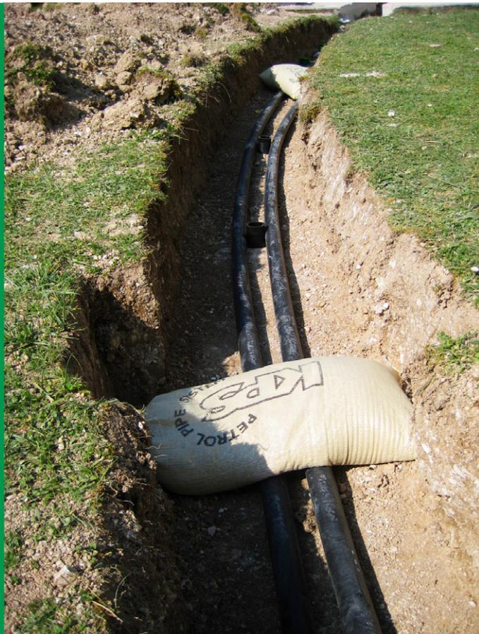
Durante la instalación utilizar sacos de arena para mantener las tuberías en su sitio.
