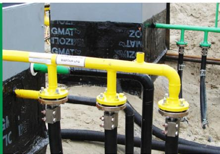
Colector preparado para ser montado con la válvula de descarga de seguridad.
