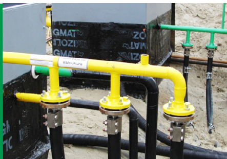
Rozgałęzienie przygotowane do montażu zaworu bezpieczeństwa.
