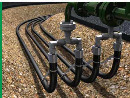
Rozgałęzienie przewodów LPG.
