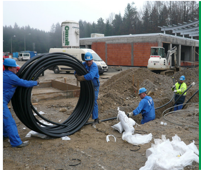
Modalità corretta per srotolare il tubo
