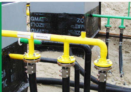
Collettore preparato per il montaggio di una valvola di sicurezza.
