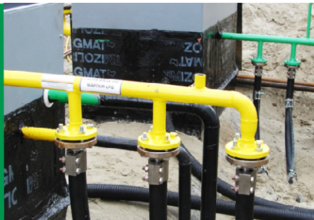
Verzweigung, die für die Installation eines Sicherheitsventils vorbereitet wurde.
