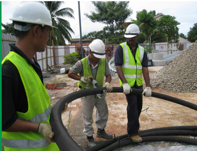
Eine Person sollte das Rohr festhalten, die andere schneiden.
