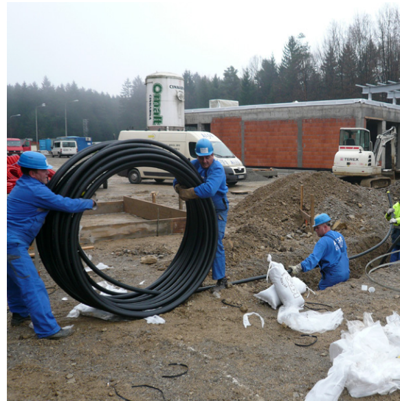
Eine gute Methode, das Rohr zu entrollen
