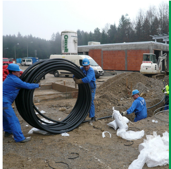
Dobar način rolanja cijevi
