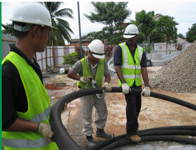
Jedan radnik treba držati cijev, a drugi vršiti rezanje.
