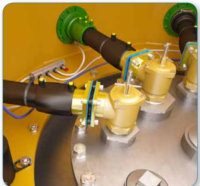
La unidad de detección de fugas debe conectarse a un KP T o a un KP TM.
