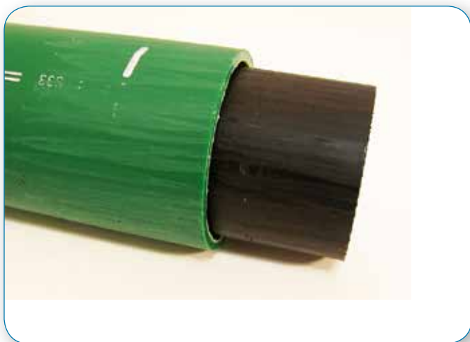
Lijado insuficiente. No se han lijado todas las áreas.
