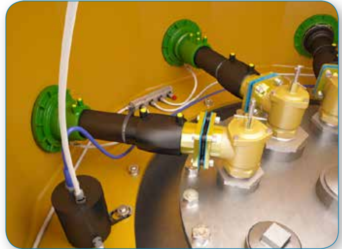
Sistema de detección de fugas KP 315.
