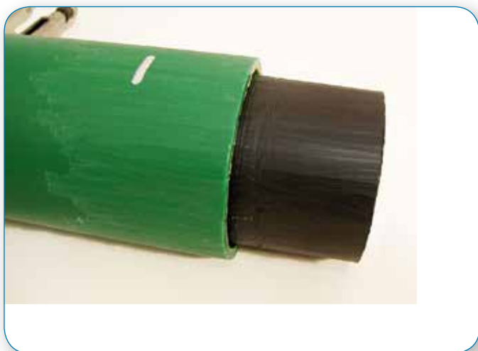
Tubos lijados correctamente. El óxido ha sido eliminado de toda la superficie que se va a soldar.
