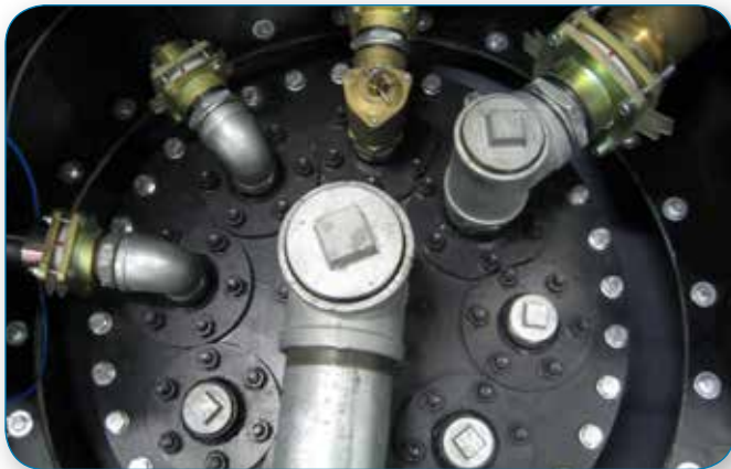
Conexiones en una tapa de tanque con accesorios de brida y válvulas de retención.
