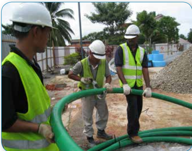
Una persona ha de sujetar el tubo y otra efectuar el corte.
