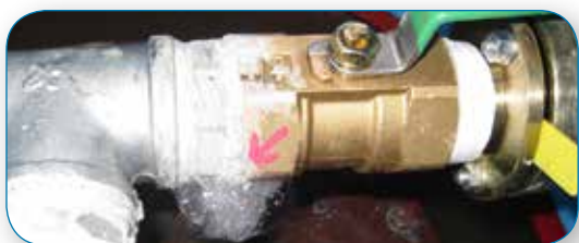
La formación de burbujas es una indicación segura de fuga.
