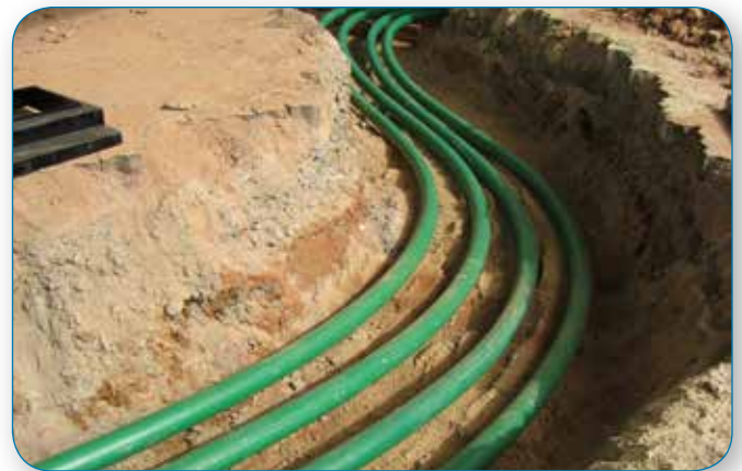
Tuberías de rollo formando curvas suaves que permiten que las tuberías se ajusten a los cambios de temperatura o a los movimientos del suelo.
