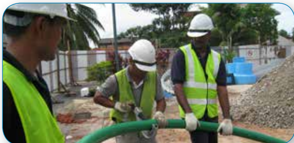
Una persona ha de sujetar el tubo y otra efectuar el corte.
