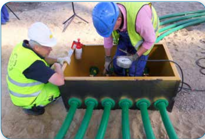
Christian Niejahr, de OPW Suecia, colabora con un instalador in situ.
