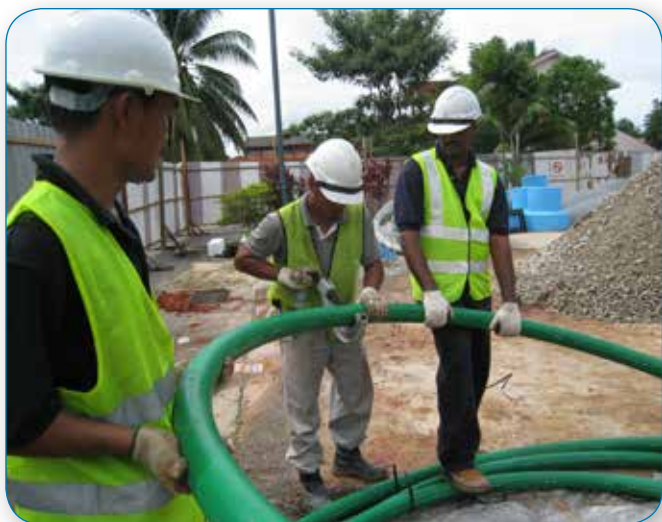
Один человек должен держать трубу, а другой — выполнять обрезку.
