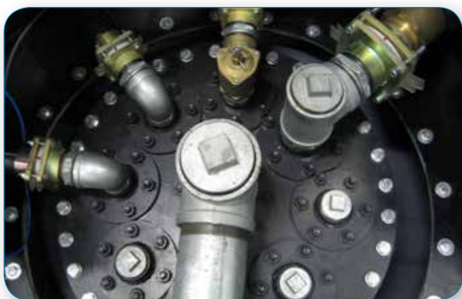
Соединения крышки резервуара с фланцевыми фитингами и отсечными клапанами.
