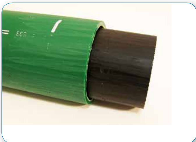
Недостаточная зачистка. Зачищены не все участки.
