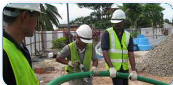
Один человек должен держать трубу, а другой — выполнять обрезку.
