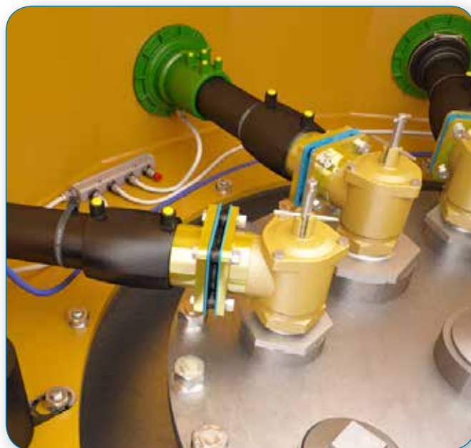
Датчик утечек должен подключаться к KP T или KP TM.
