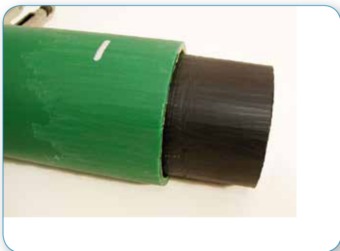
Правильно зачищенные трубы. Окисная пленка удалена со всей свариваемой области.
