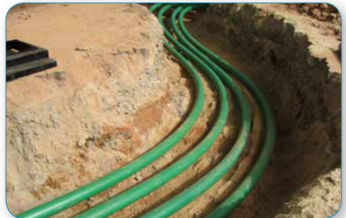
Трубопровод из бухты укладывается с небольшими изгибами, что позволяет трубе приспособиться к изменениям температуры и смещениям земли.
