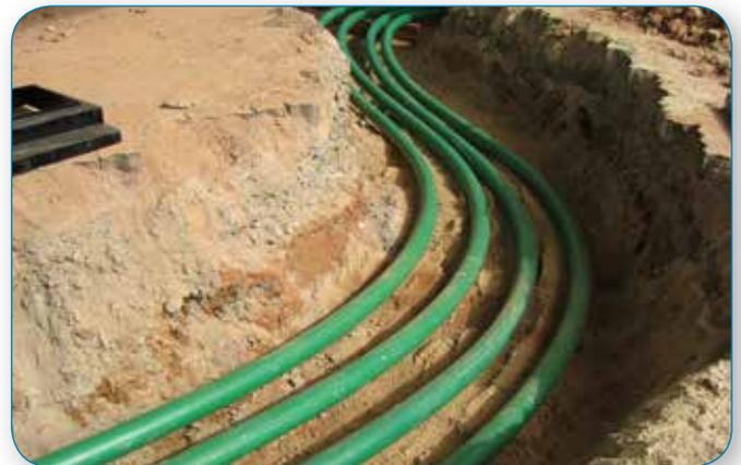
*Tubi arrotolati disposti con curve morbide permettono ai tubi di assecondare le variazioni di temperatura o i movimenti del terreno.*
