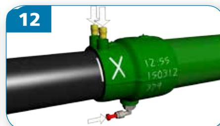
Chiudere la porta per test e applicare i tappi antistatici dopo il test di pressione.
