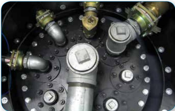
Collegamenti al coperchio del serbatoio mediante raccordi flangiati e valvole di intercettazione.
