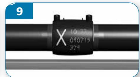
Controllare che i tubi non si siano mossi durante la saldatura. Controllare che gli indicatori di saldatura siano fuori. (testimoni)
