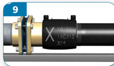
Controllare che il tubo e il raccordo adattatore non si siano mossi durante la saldatura. Controllare che gli indicatori di saldatura siano fuori. (testimoni)
