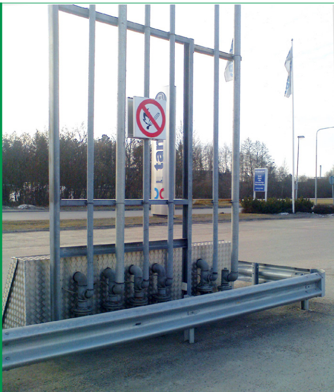
Należy zastosować bariery ochronne w celu zabezpieczenia masztów oddechowych i punktów zrzutu paliwa przed uszkodzeniami.
