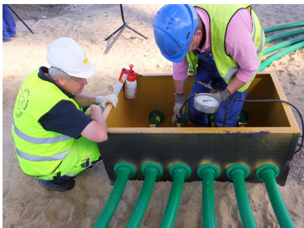
Christian Niejahr z KPS Sweden pomaga instalatorowi w miejscu montażu instalacji.
