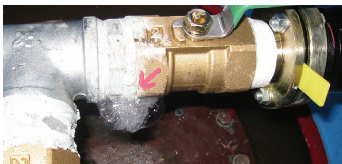
出现气泡明确表示存在渗漏。
