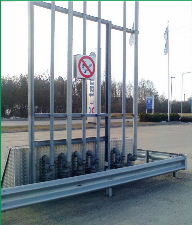
应使用防撞护栏，以保护通气竖管和卸油点免遭损坏。
