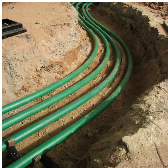
稍微弯曲敷设盘管，以便管道适应温度变化或地面运动。
