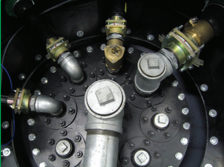
油罐人孔盖与法兰接头和切断阀的连接。
