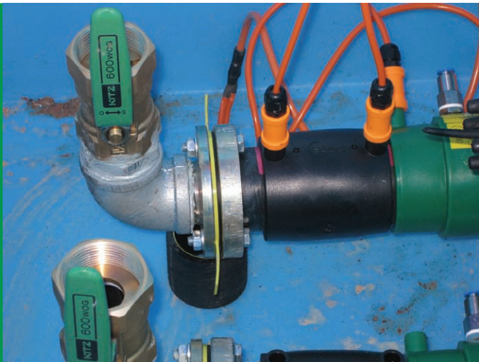
在焊接过程中，支撑人孔井内部和外部的管道。
