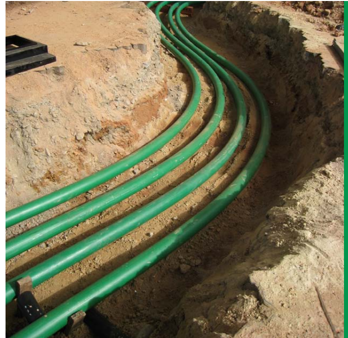
Kelalla toimitetut putket loivasti kaartuen, mikä mahdollistaa putken mukautumisen lämpötilan muutoksiin ja maan liikkeisiin.
