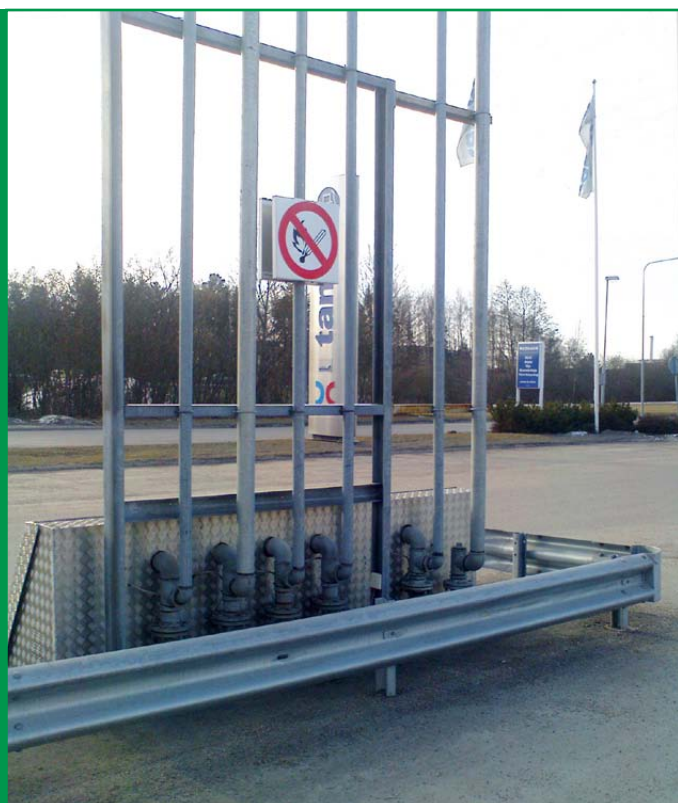
Liikennesulkuja on käytettävä tuuletuspiipuston ja täyttöpisteen suojaamiseen vahingoittumiselta.
