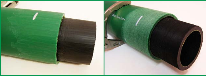
Oikein kaavitut ja hiotut putket. Oksidi on poistettu koko hitsattavalta alueelta.
