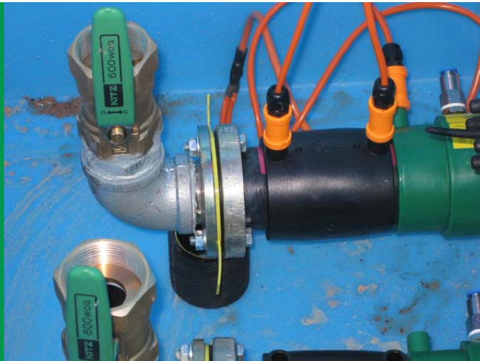
Tue putkea kaivon sisäpuolella ja ulkopuolella hitsauksen aikana.
